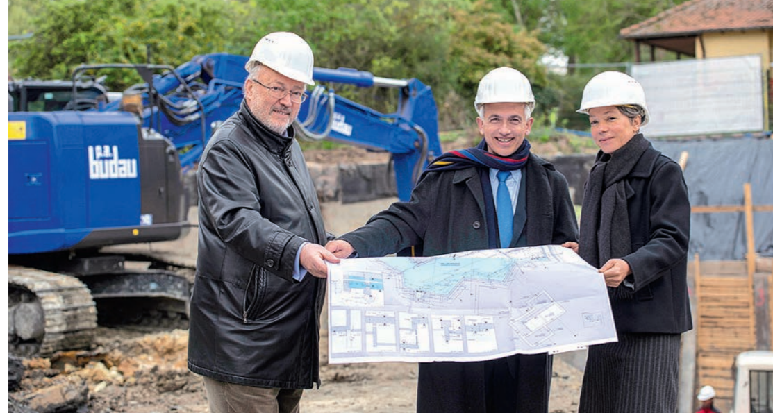
Am 25. April – dem internationalen Tag der Pinguine – informierte Zoodirektor Dr. Manfred Niekisch Oberbürgermeister Peter Feldmann und Kulturdezernentin Dr. Ina Hartwig (v.l.n.r.) über die Fortschritte auf der Baustelle.
