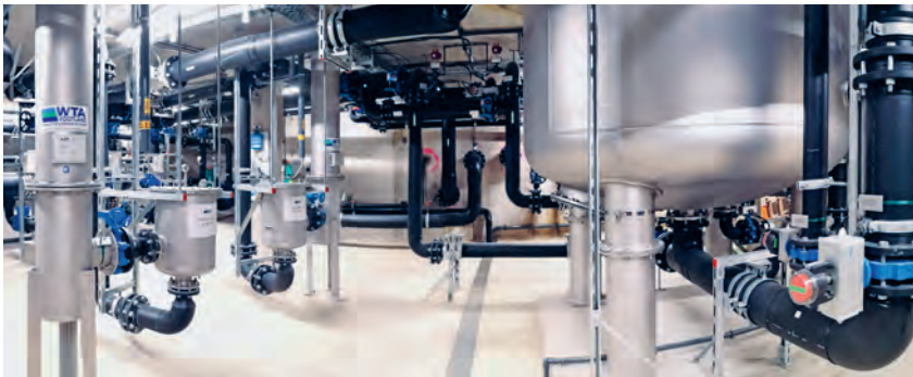
oben: Bereits der Rohbau ließ die Größ- räumigkeit der Anlage erkennen.
